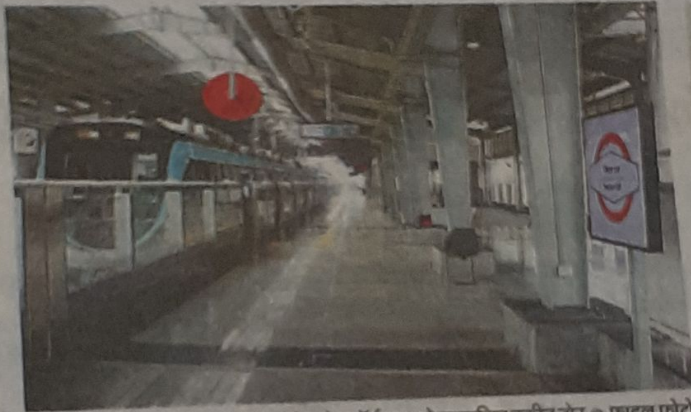
एक्वा लाइन कॉरीडोर के मेट्रो स्टेशन के प्लेटफॉर्म पर लगे स्वचालित स्क्रीन डोर • फाइल फोटो
